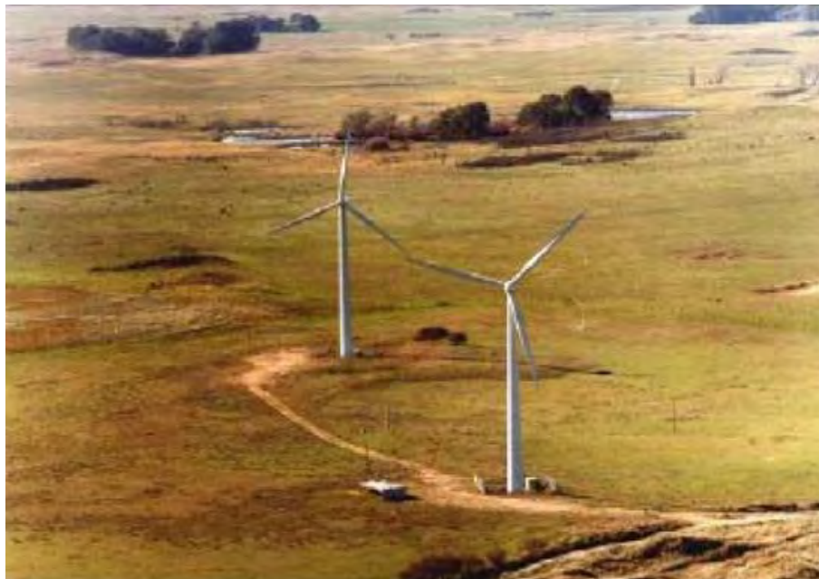
Figura N° 75. Parque Eólico Mayor Buratovich. Año 1997.
