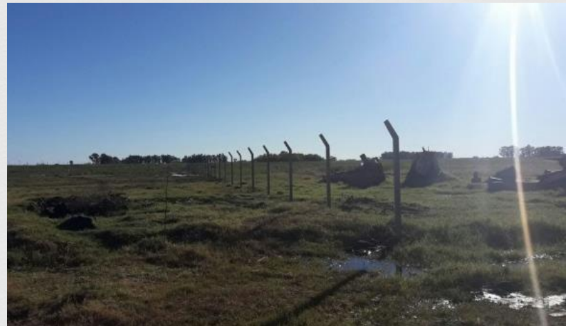
Parque Solar Cañada Seca 500 kW- Surland
